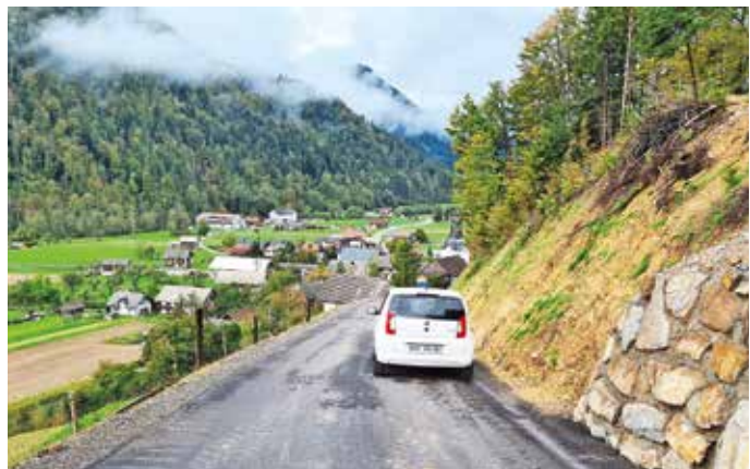
Asfaltirali so tudi slabih 400 metrov ceste od Selc proti Topoljam. / Foto: Ana Šubic
